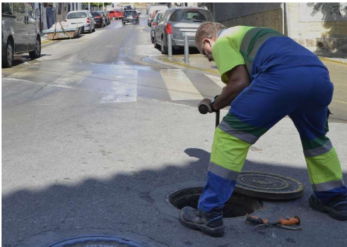
Un operario de Emalgesa en la calle María Auxiliadora, en foto de archivo.
