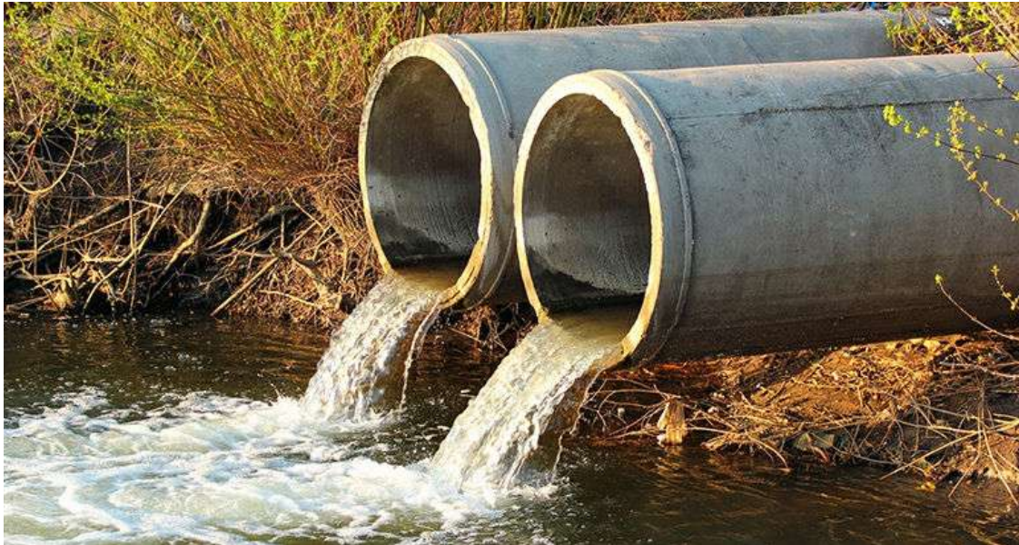
ACUAES licita la nueva EDAR de El Marco para modernizar el saneamiento de Cáceres
