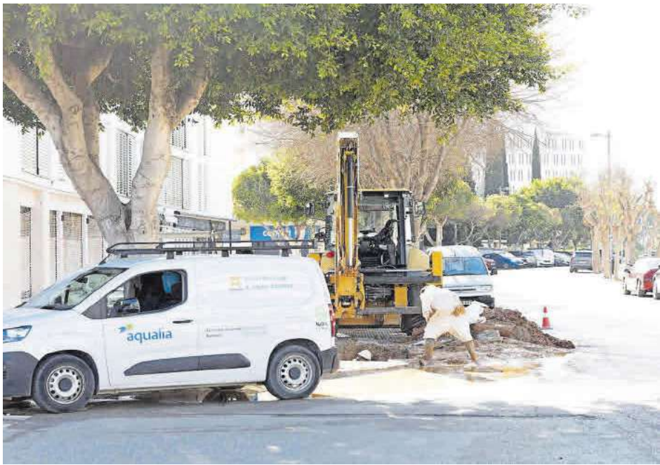
Un momento de la reparación de la avería.
